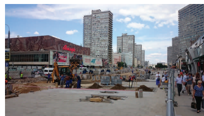
Реконструкция ул. Новый Арбат
