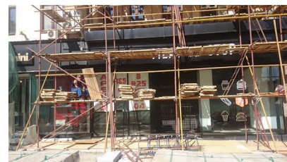
Реконструкция Тверской ул.
