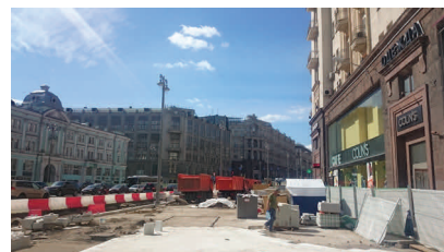
Реконструкция Тверской ул.
